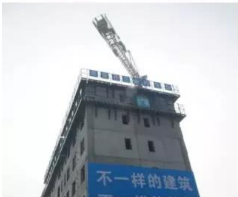
中建·深港新城项目（在建 中建三局） （6幢，装配率78%）
